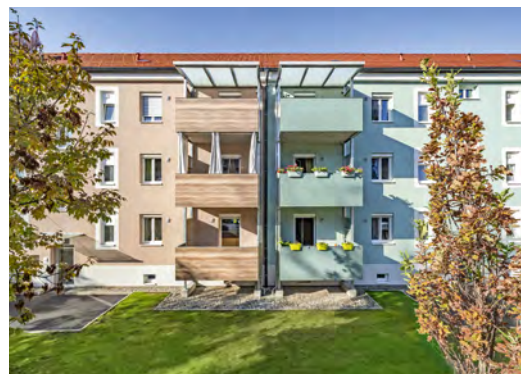
Der Bestandsbau in der Hermann-Löns-Gasse im Bezirk Gries wurde umfassend thermisch saniert und mit Balkonen aufgewertet.
