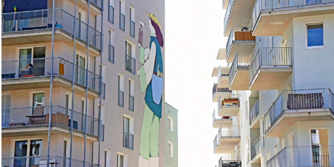
Campagne: Fertigstellung Baufeld 1 mit Mural
