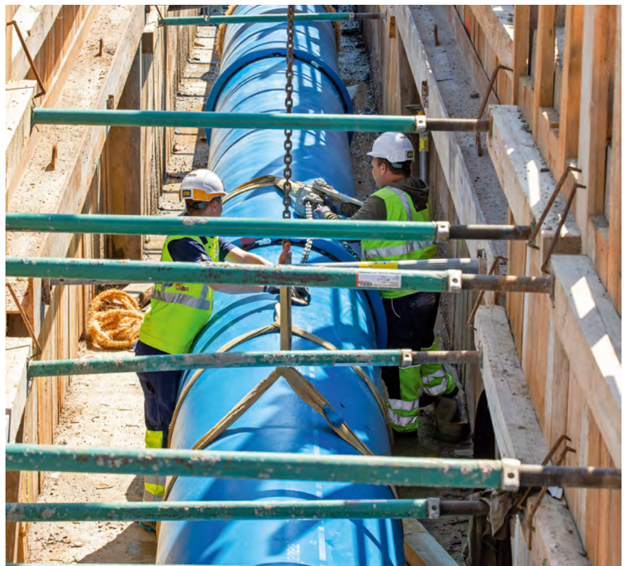
Im Westen Wiens entsteht eine neue Trinkwasser-Transportleitung.
