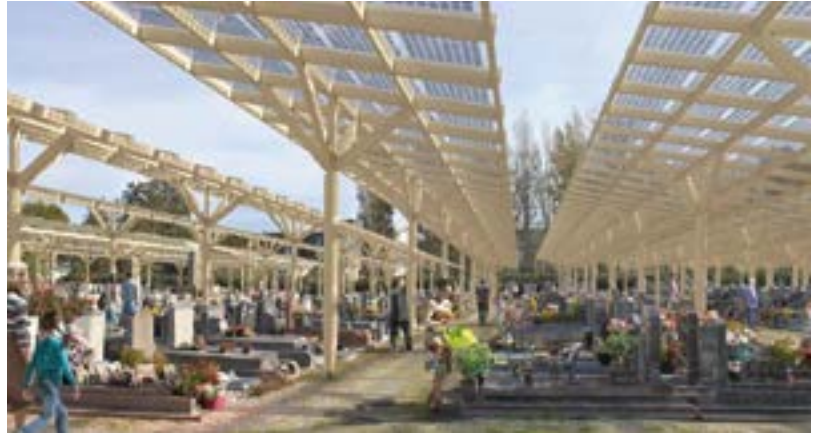
Solarpaneele spenden Schatten, sammeln Regenwasser und erzeugen Energie.
