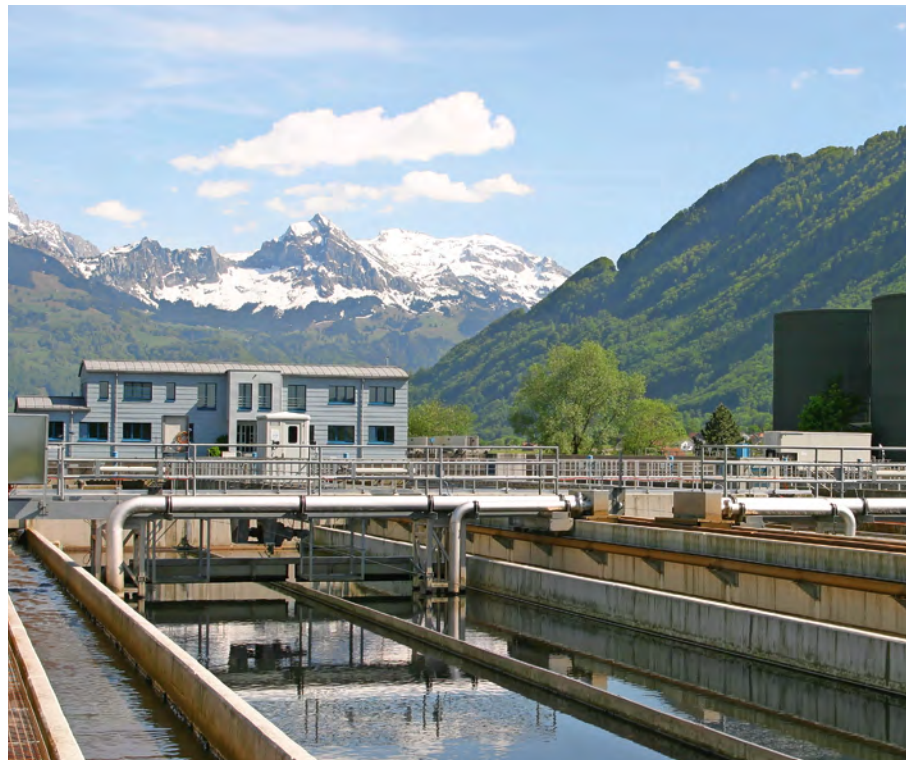
Abwasserreinigungsanlage in den Alpen
