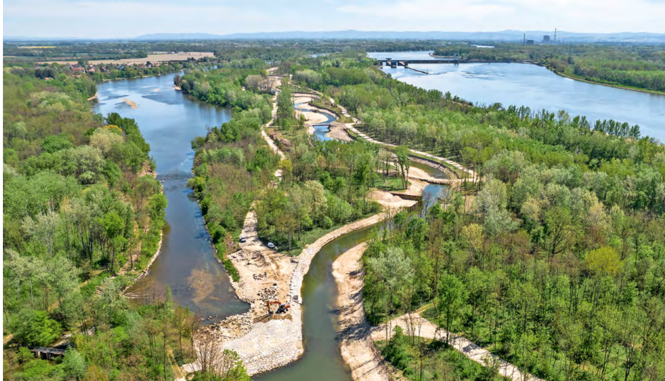
11 Kilometer lange Fischwanderhilfe beim Donaukraftwerk Altenwörth
