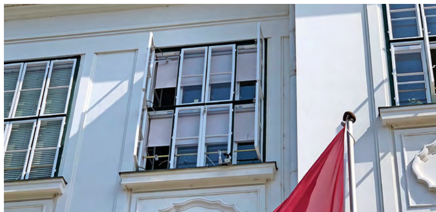
Abb. 2: Testbüro an der Südfassade des Altbaus der Universität für Weiterbildung Krems: Zustand kurz vor morgendlicher Schließung des Fensters und Aktivierung der beiden Verschattungsrollos
