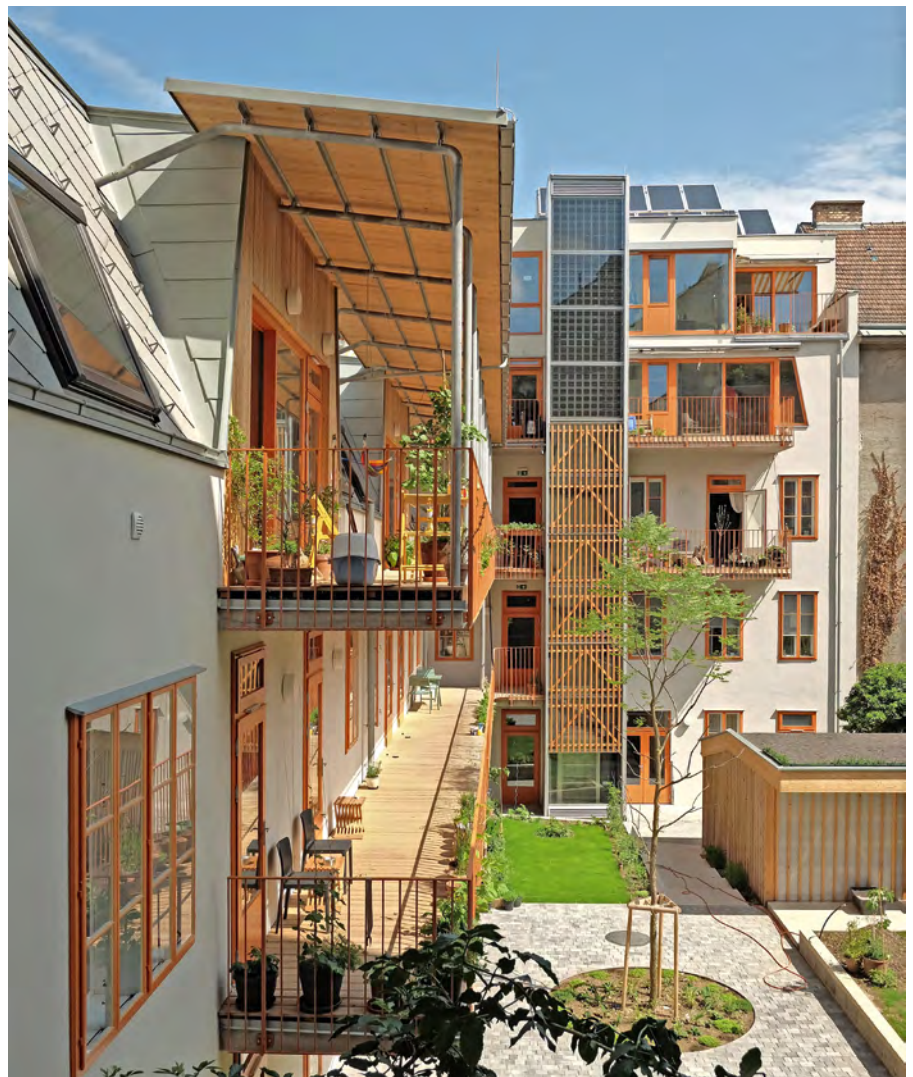
Anergienetz „Smart Block Geblergasse“ in 1170 Wien, unter dem Innenhof befinden sich die Erdwärmesonden.
