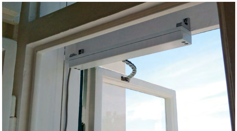
Abb. 1: Historisches Kastenfenster mit aufgesetzter Motoreinheit (Kettenantrieb) an der Universität für Weiterbildung Krems aus CoolAIR
