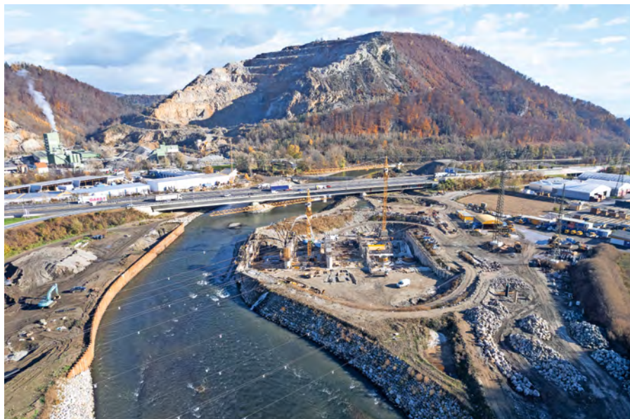
Baustelle des Gemeinschaftskraftwerks Gratkorn an der Mur (Stmk.)
