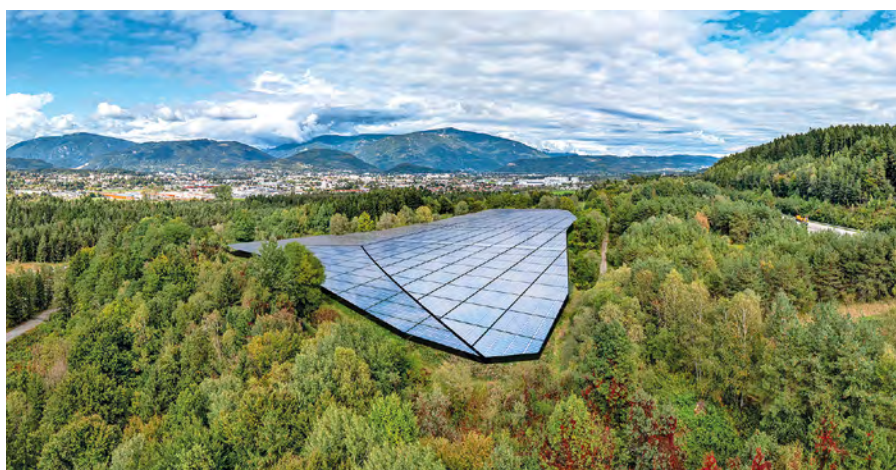
Am Villacher Stadtrand wird Kärntens größte PV-Anlage entstehen.
