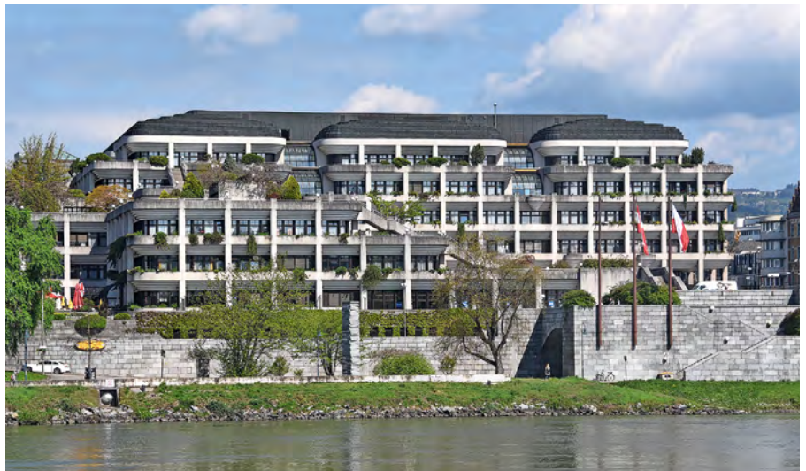
Neues Rathaus Linz: mit Notstromaggregat gerüstet
