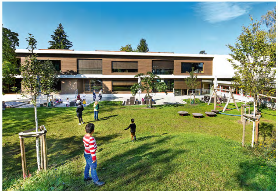
Passivhauskindergarten St. Gebhard mit Biodiversitätsgründach, Photovoltaikanlage und naturnaher Außenraumgestaltung
