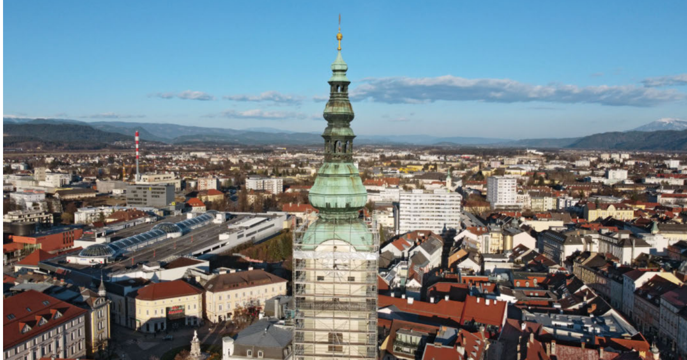
Drohnenaufnahme von der Kirchturm-Renovierung
