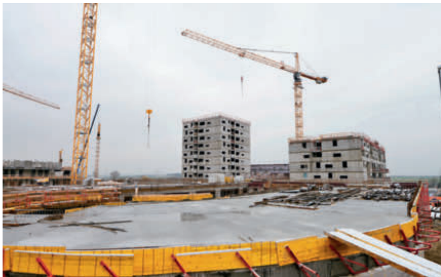
Gleichenfeier des ersten „Gemeindebau NEU“ in der Fontanastraße 3 in Favoriten im November 2018
