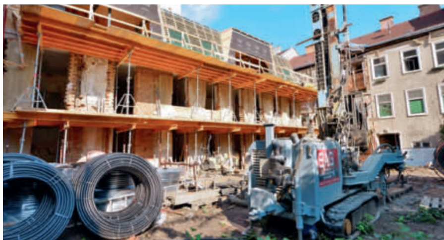
Baustelle während der Tiefenbohrungen im Innenhof
