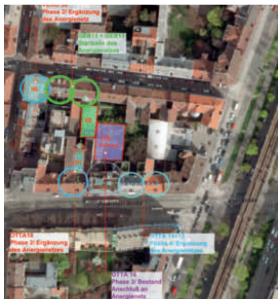
Luftbild Gründerzeit-Häuserblock des Pilotprojekts „Anergienetz 1170 Wien“
