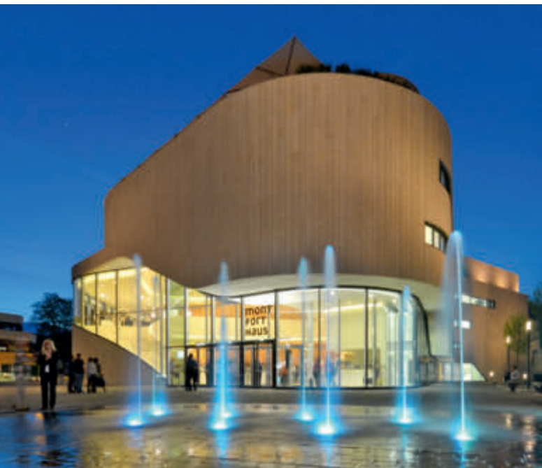
Das Montforthaus – „Green building“ und Leuchtturmprojekt in Sachen Energieeffizienz.
