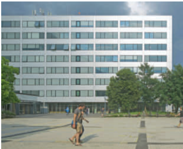
Sanierung Gebäude der Technischen Wissenschaften (Tirol)
