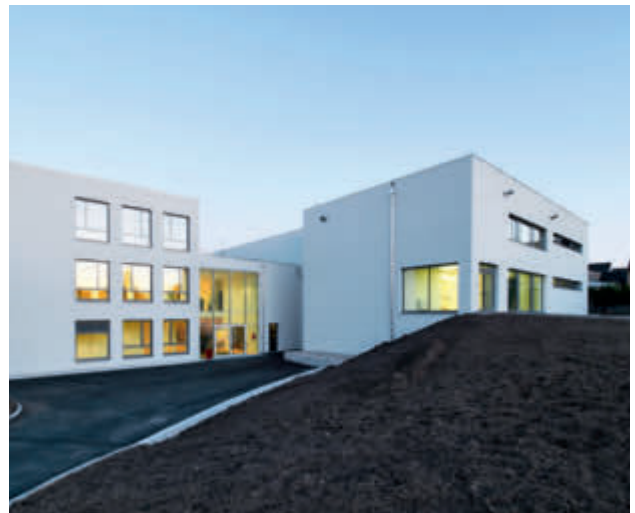
Volksschule und Turnsaal Ziersdorf (NÖ), Mustersanierung
