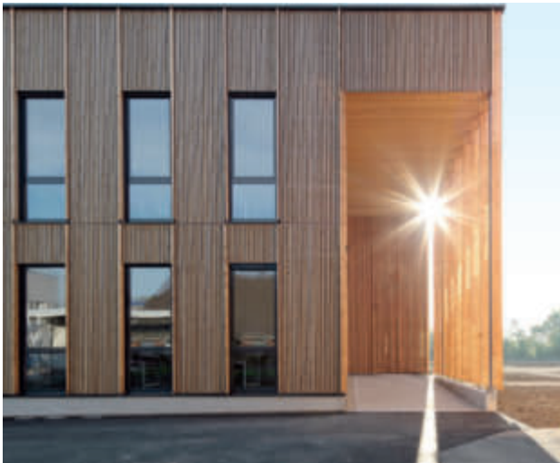
Labor- und Bürogebäude IFA Tulln (NÖ)
