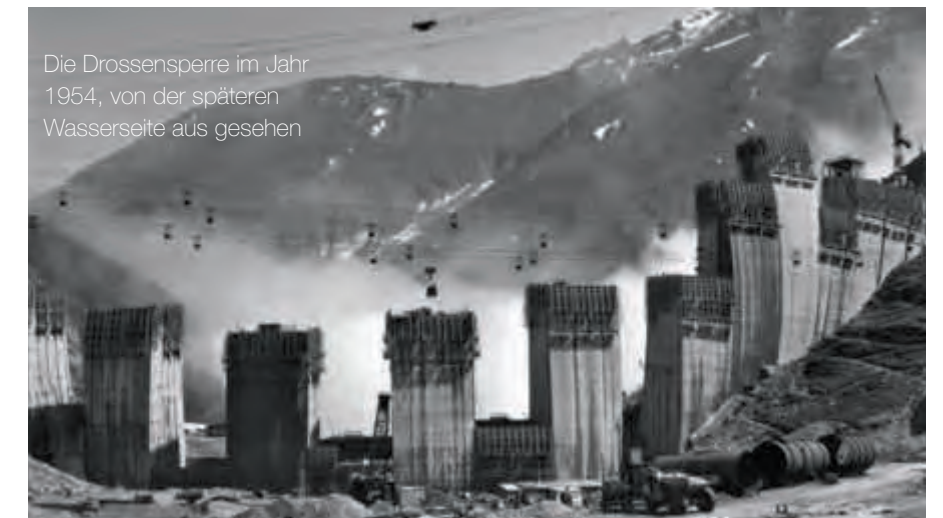
Errichtung einer Talsperre: Betonierer bei der Arbeit
