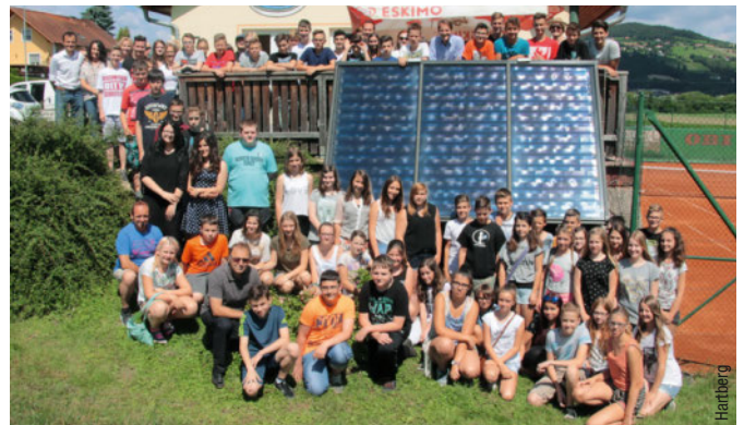
Die neue Solaranlage vor dem Tennishaus in Safenau mit SchülerInnen, LehrerInnen und GemeindevertreterInnen.
