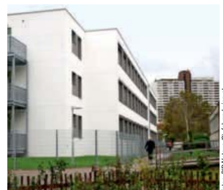
HOLZZUBAU DER VS ERLAAER SCHLEIFE.
