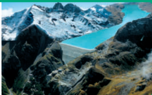
WASSERKRAFT als sauberer Stromlieferant
