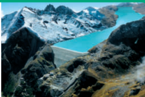
WASSERKRAFT als sauberer Stromlieferant
