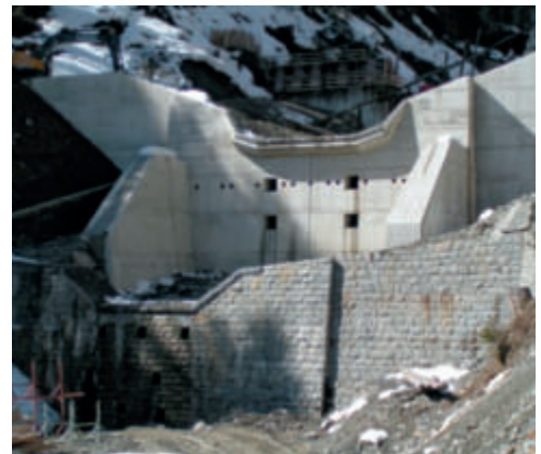
Pflege und Instandhaltung sind wesentliche Faktoren bei Hochwasserschutzbauten
