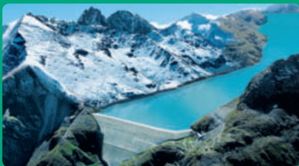
WASSERKRAFT als sauberer Stromlieferant
