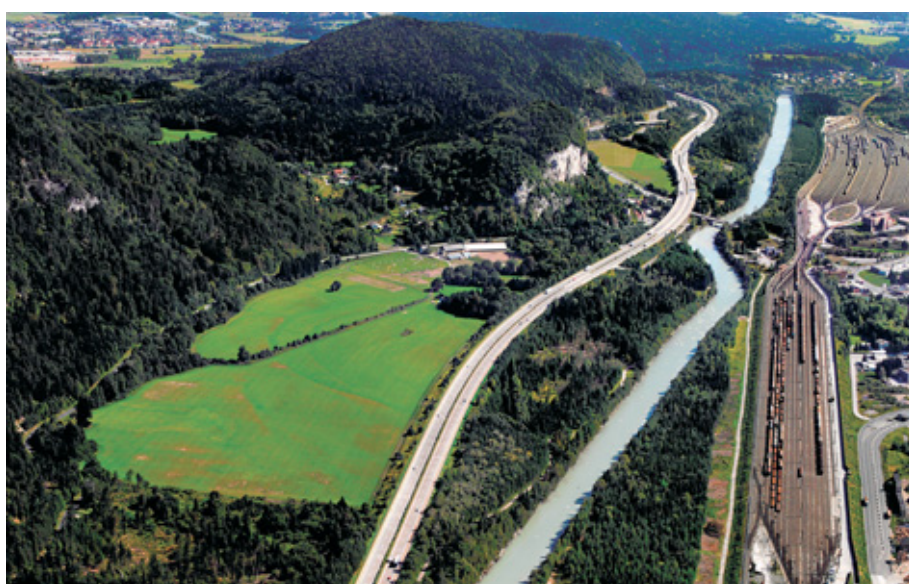
Im Bereich Villach-Federaun, im Süden des Stadtgebietes und in unmittelbarer Nähe zur Autobahn, sicherte sich die Stadt Villach wertvolle Grundstücksreserven für zukünftige Betriebsansiedlungen.
