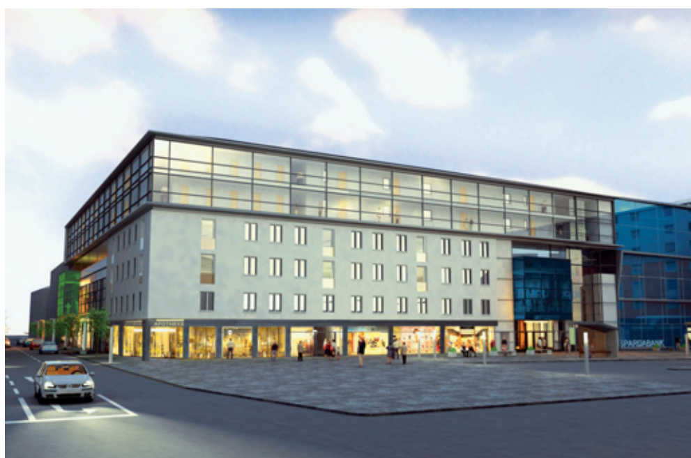
Im Zuge der breit angelegten Villacher Altstadtoffensive und Erneuerung des Bahnhofsviertels wurde Ende März feierlich der Spatenstich für das neue EKZ „Draupassagen“ gesetzt.
